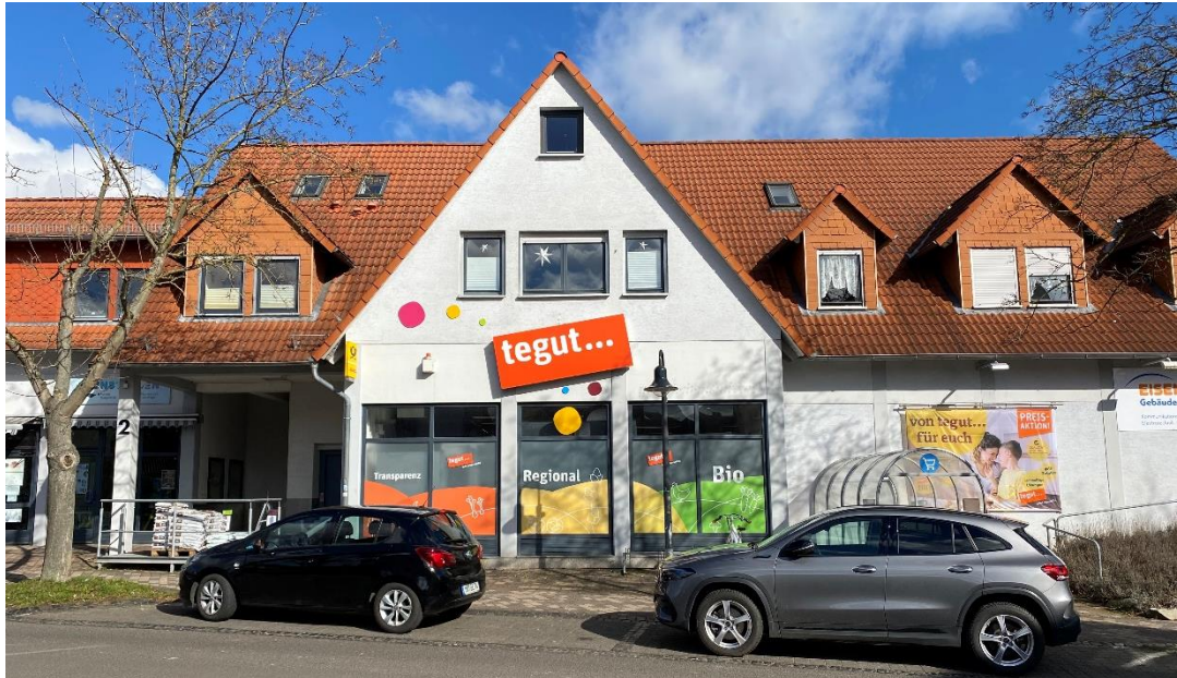
Abbildung 10: Tegut-Markt in der Straße Zum Kurpark (Zone 1)
