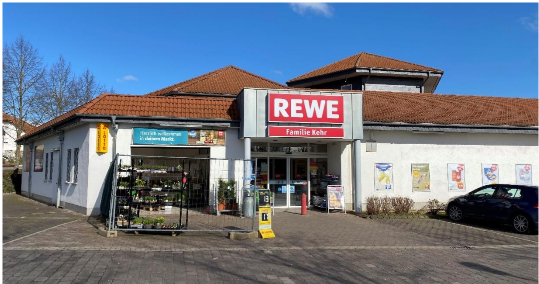
Abbildung 4: Prüfobjekt in der Kasseler Straße
